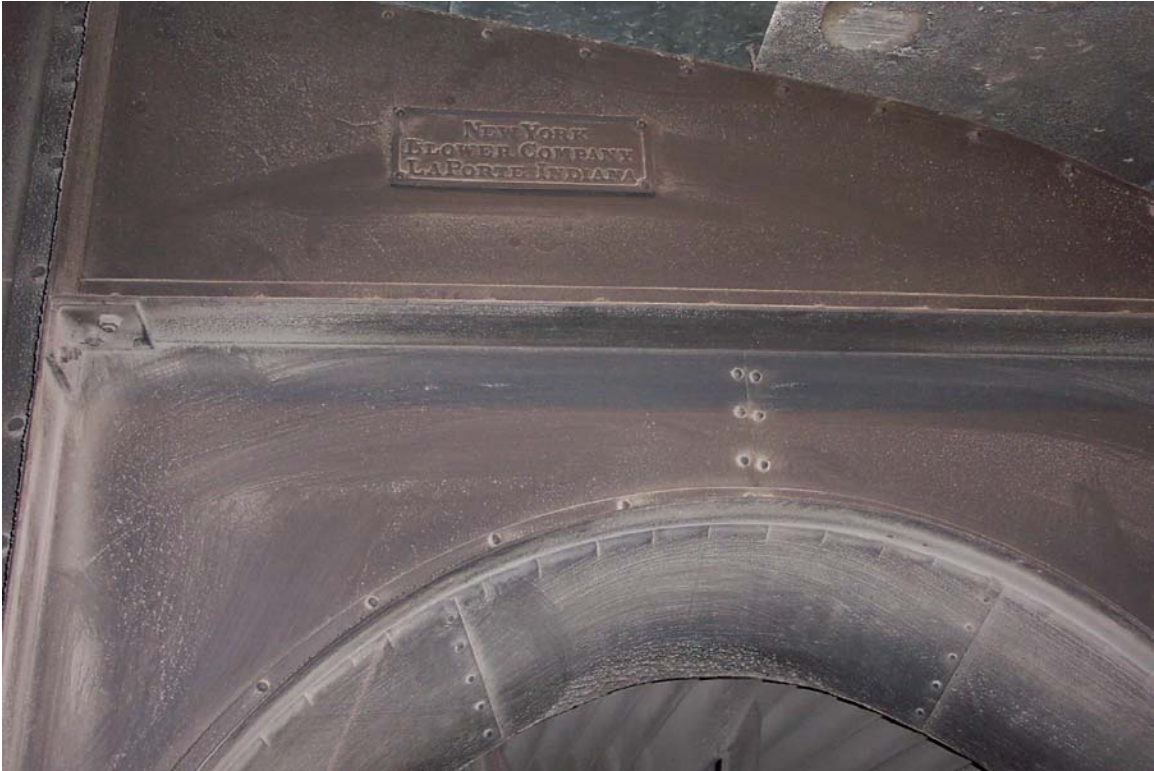
Fig 28 Return air fan casing
