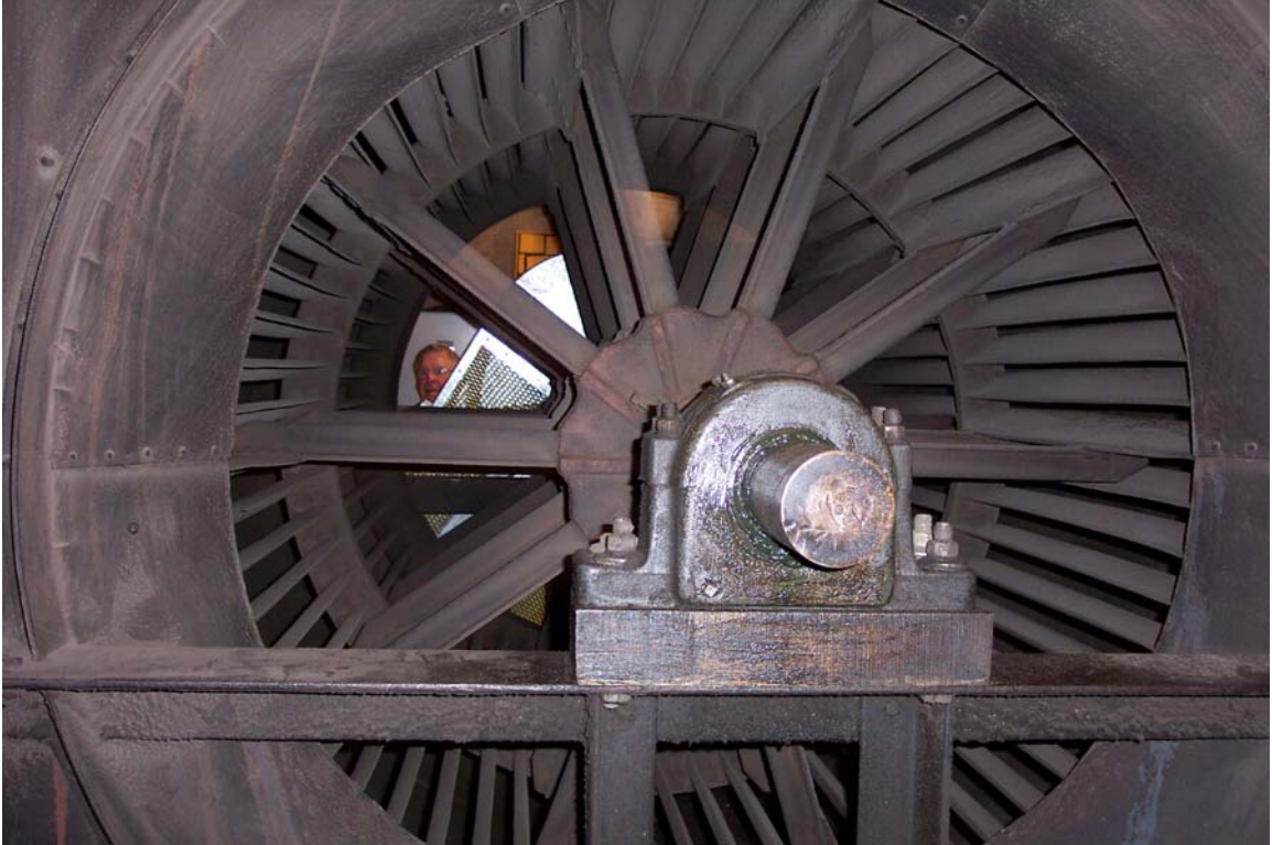
Fig 26 75000 CFM return air fan
