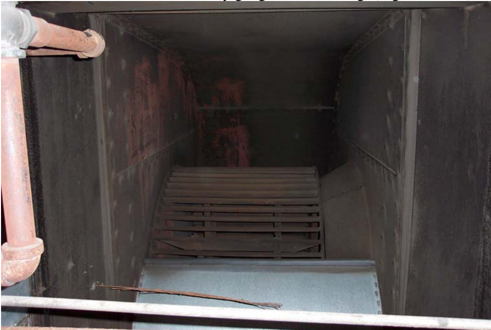
Fig 25 Supply air fan outlet.
